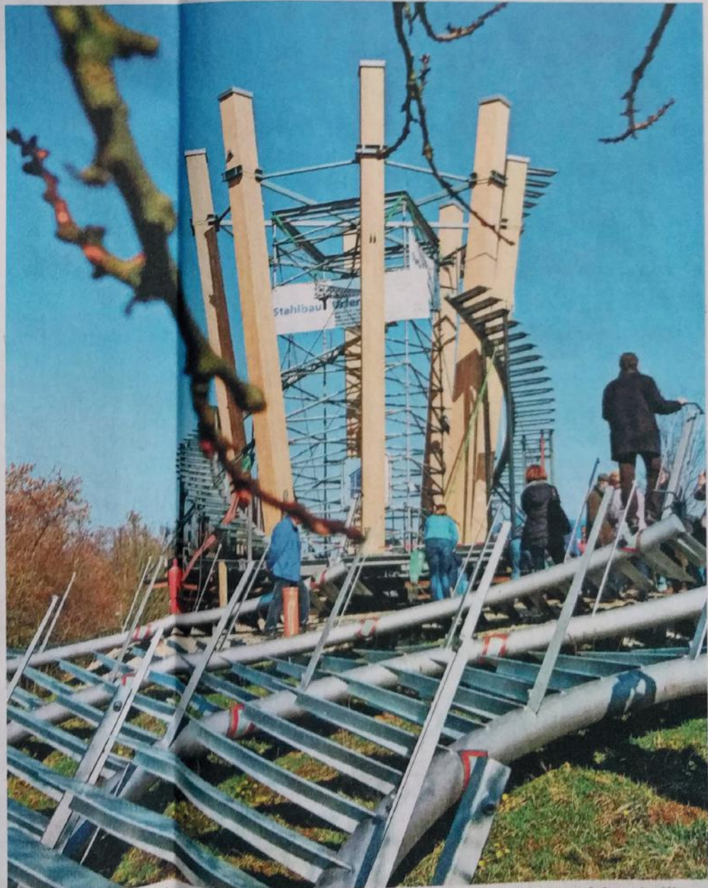
Das erste Element der Turmkonstruktion steht bereits fertig montiert auf dem Stellberg. Für Juni ist die offizielle Eröffnung geplant.
